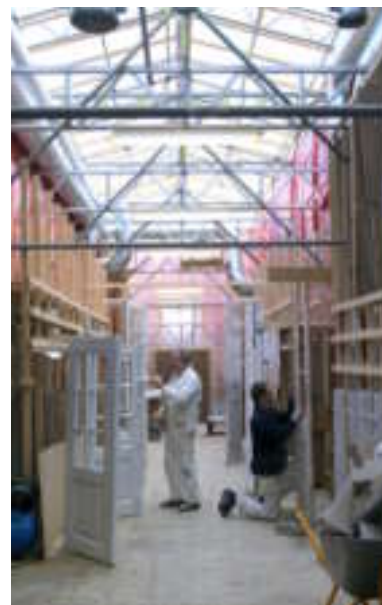
På Amalienborg er der midlertidigt etableret et værksted bag Frederik 8.'s Palæ, hvor vinduerne bliver istandsat i forbindelse med det igangværende renoveringsarbejde.
